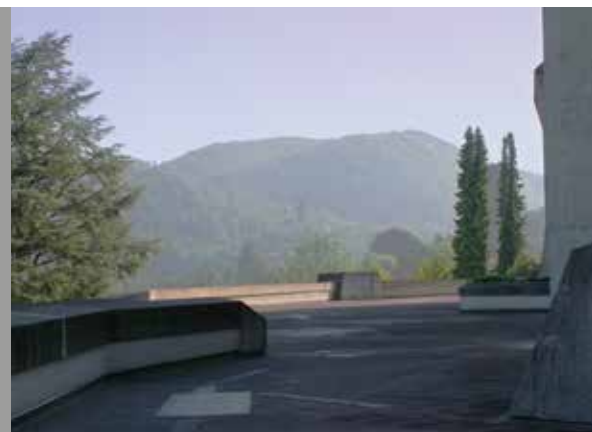
Terrasse, provisorische Abdichtung
