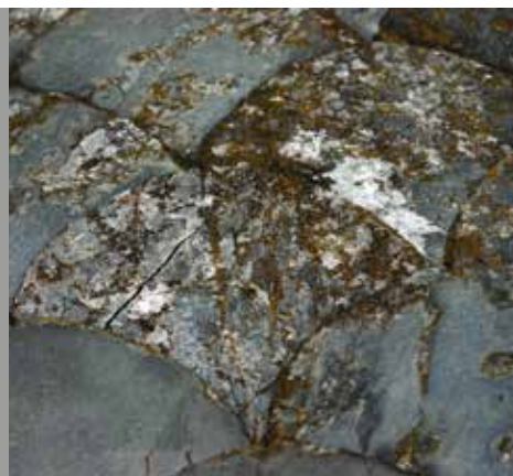
Schadhafter Dachschiefer
