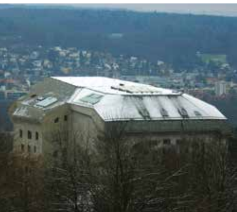
Isolierte und unisolierte Dachflächen
